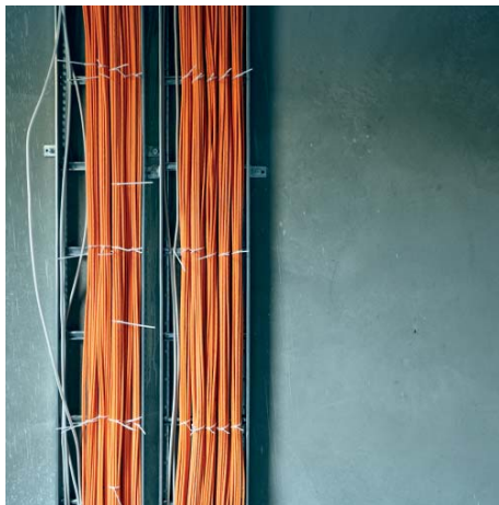
Unmengen von Kabelbahnen vernetzen Unternehmen mit ihrer Umwelt. Aber wer alles kann diese Kabel anzapfen?
